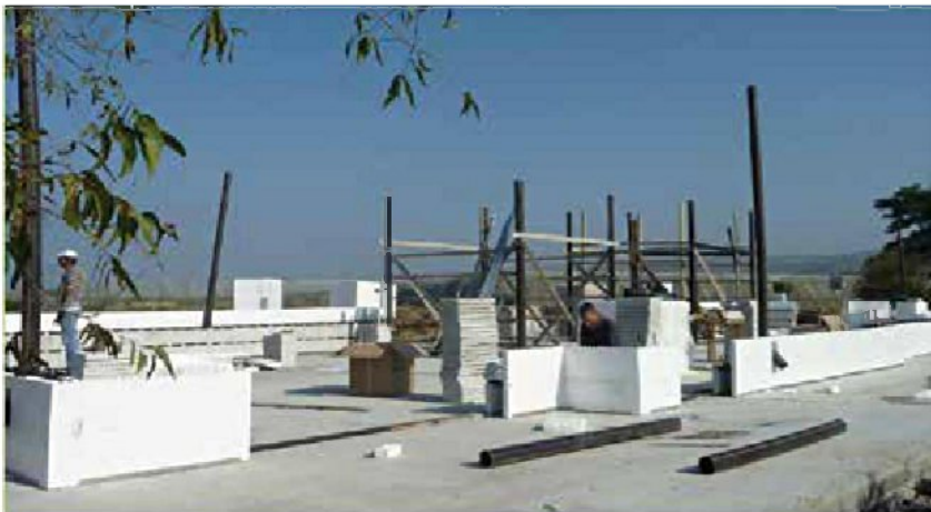
השלב הראשון של בניית מבנה בשיטת GSB, שבו מורכבים פאנלי הקלקר של הבידוד החיצוני זה על גבי זה
