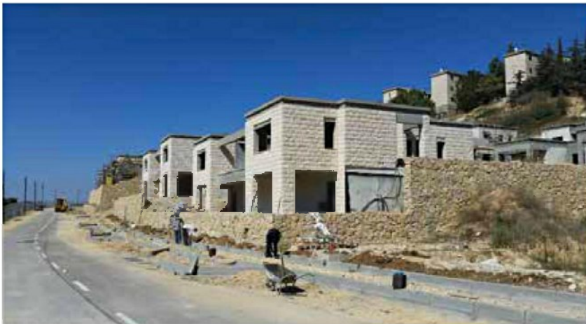
הבתים מחופי האבן על הבידוד החיצוני בקיבוץ סאסא לפני השלמתם
