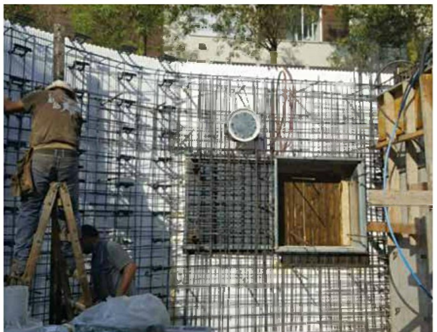
שלב הזיון במסבכי פלדה לפני הנחת הבלוקים ויציקת הבטון לתוכם בבניין צמוד קרקע שנבנה בשיטה החדשנית בתל-אביב
